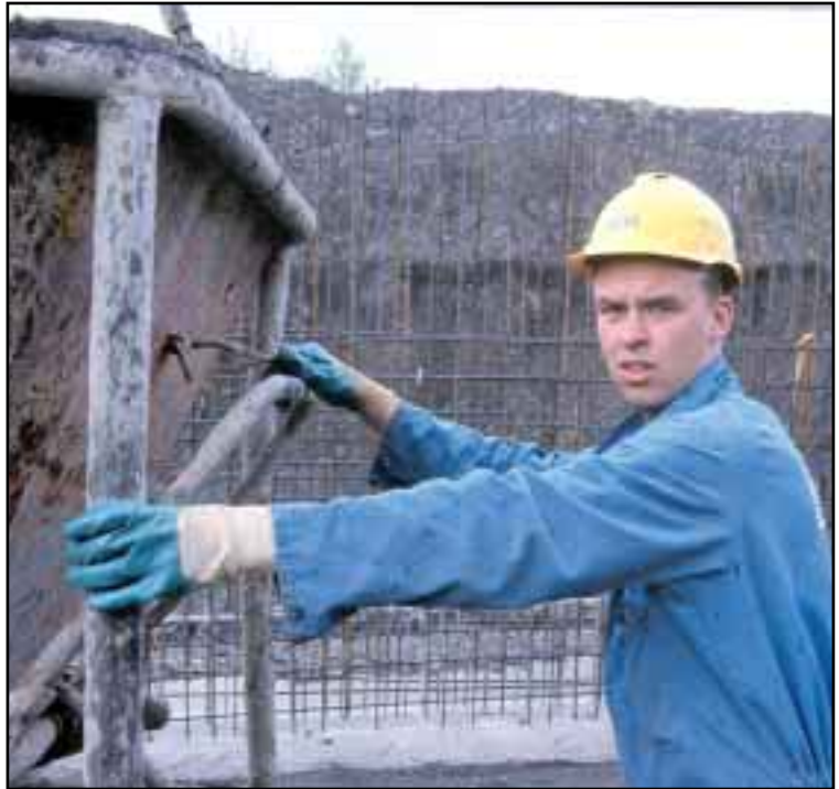
Í mörgu að snúast, segir Helgi Sigurðsson við steypusílið
