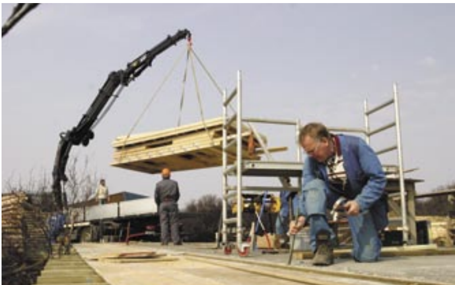
Íðnaðarmenn voru mættir með tól og tæki þegar húseiningarnar voru híðar á steypa plötu og húsið svo reist á nokkrum klukkutímum.
