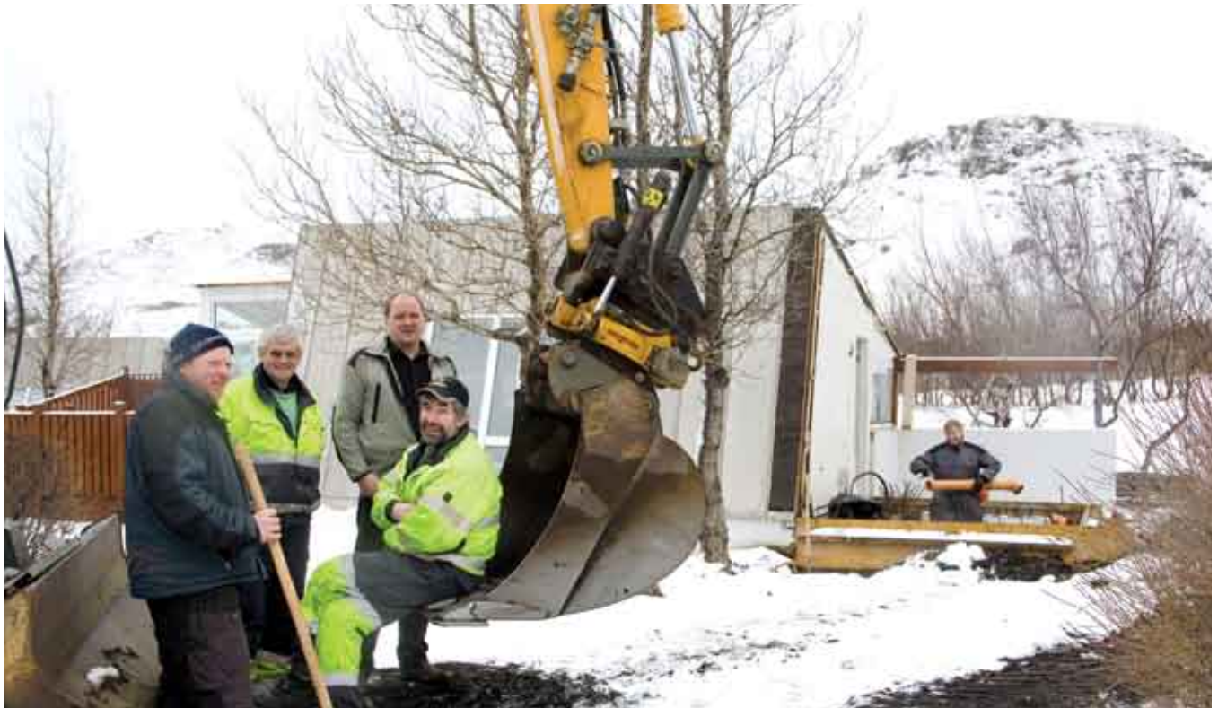
Öflugir menn og tæki - búíð að rífa skemmda hlutann og byrjað að byggja upp
