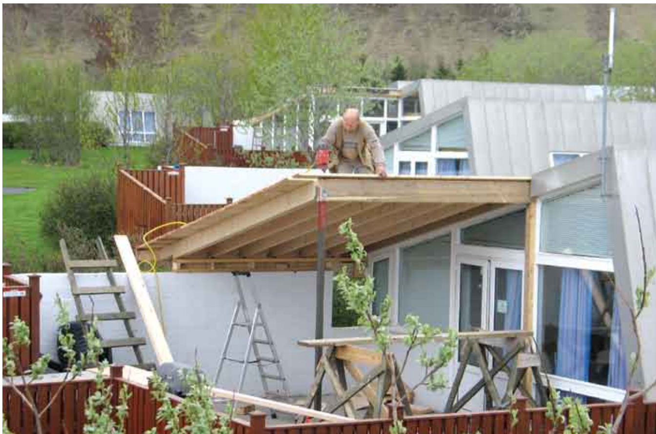
Unnið við þak sólskála...
