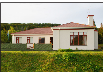
Hvammur í Skorradal
